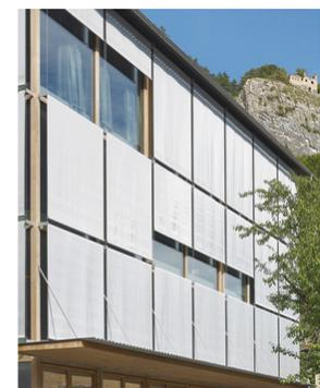
Fassadenreferenz mit außenliegendem selbgeführt Sonnenschutz aus Screengewebe
